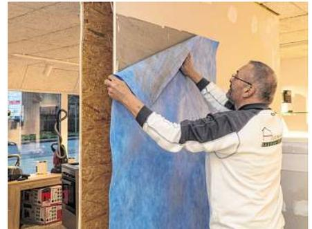
Kay Jäkel zeigt wie eine Dichtbahn als Untergrund für Fliesen angebracht wird. Sie verhindert das Eindringen von Feuchtigkeit.
